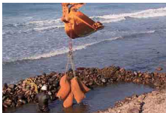
図2 ビバリー ® ユニットの埋設工事の様子
